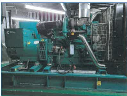
ภาพถ่ายที่ 2.2-16 เครื่องกำเนิดไฟฟ้าสำรองของโรงแรม
