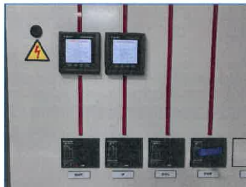
ภาพถ่ายที่ 2.2-10 ระบบมิเตอร์ไฟฟ้าของระบบบำบัดน้ำเสีย
